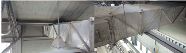
Photos prises par le drone à l'intérieur des salles de cuve
