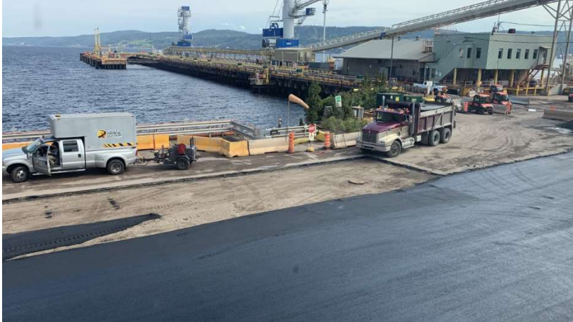
Asphaltage pour diminuer poussières et améliorer lecture des équipements de mesure de poussière
