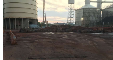
Nettoyage et valorisation du pad de fonte de neiges
