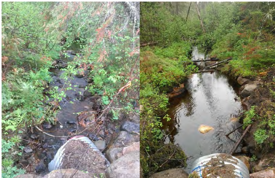
Figure 5 : Cours d'eau CE110 à la station S100 passant sous un chemin forestier (option 3).
