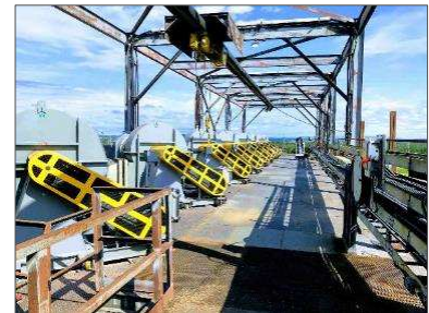
Vue des ventilateurs de l'épurateur à sec.
