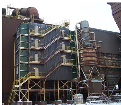
Enceinte en panneau acoustique (acier)
