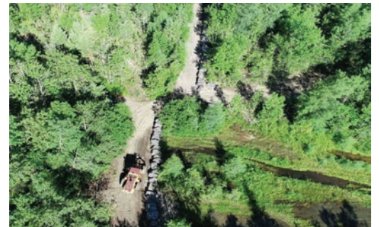
Enrochement secteur sud
