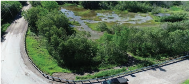
Glissière de sécurité
