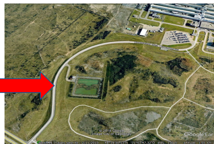
Il sert à capter et sédimenter les particules en suspension provenant des eaux de pluie et du procédé
