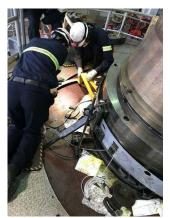
Mesure de l'inclinaison de l'arbre à l'aide de d'inclinomètres
