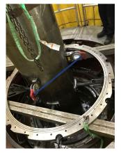
Ajustement du pallier de butée pour corriger l'axe de rotation du groupe turbine-alternateur
