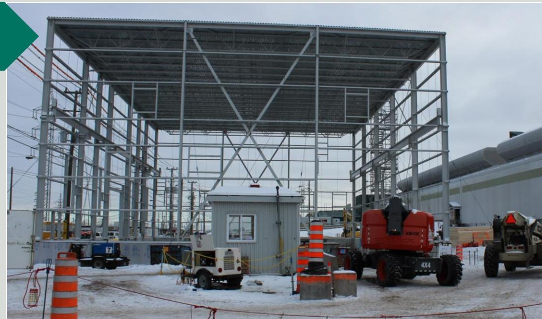
Structure du bâtiment de la salle des compresseurs
