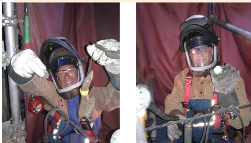
**Gastier** : Frédéric Boudreault et Mathieu Côté ont contrôlé le CRM Chute d'objets à leur poste de travail respectif en posant de la toile sur les garde-corps, en utilisant des attaches pour l'ensemble de leurs outils, en attachant leurs rallonges électriques et en rangeant leurs outillages dans des chaudières conformes.
