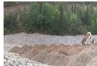
Résidus secs disposés en pile grâce à la filtration industrielle
