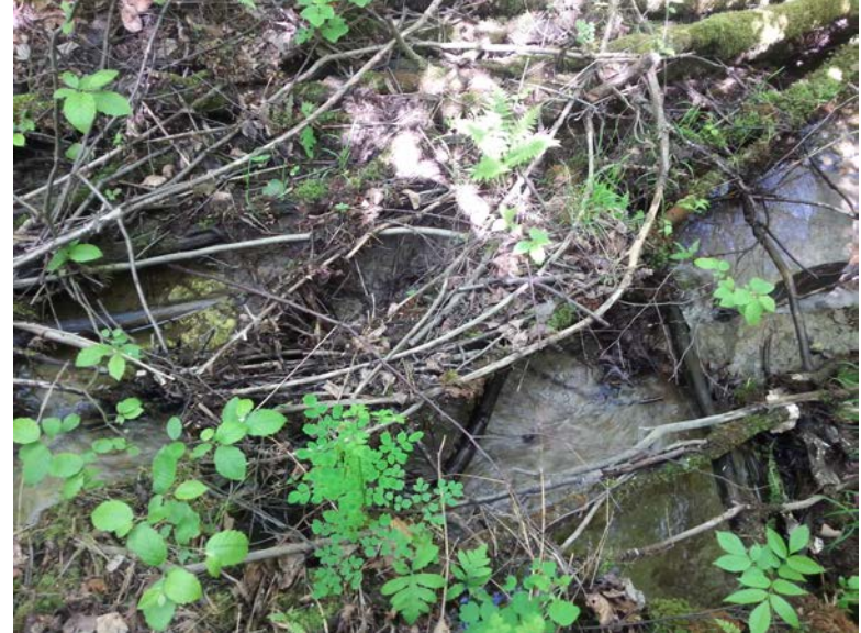
Fig. 47. Premier obstacle infranchissable pour le poisson. Accumulation de débris végétaux dans le lit d'écoulement empêchant la libre circulation de l'eau.
