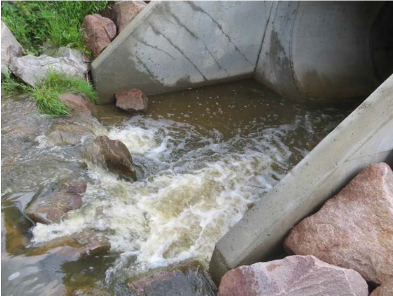
Fig. 23. La station de pêche électrique P.205 a été effectuée en amont d'un ponceau aménagé pour le cours d'eau CE200.
