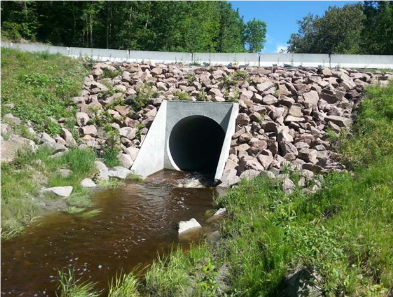
Fig. 20. Ponceau vue de la station de pêche électrique P. 205 en amont.
