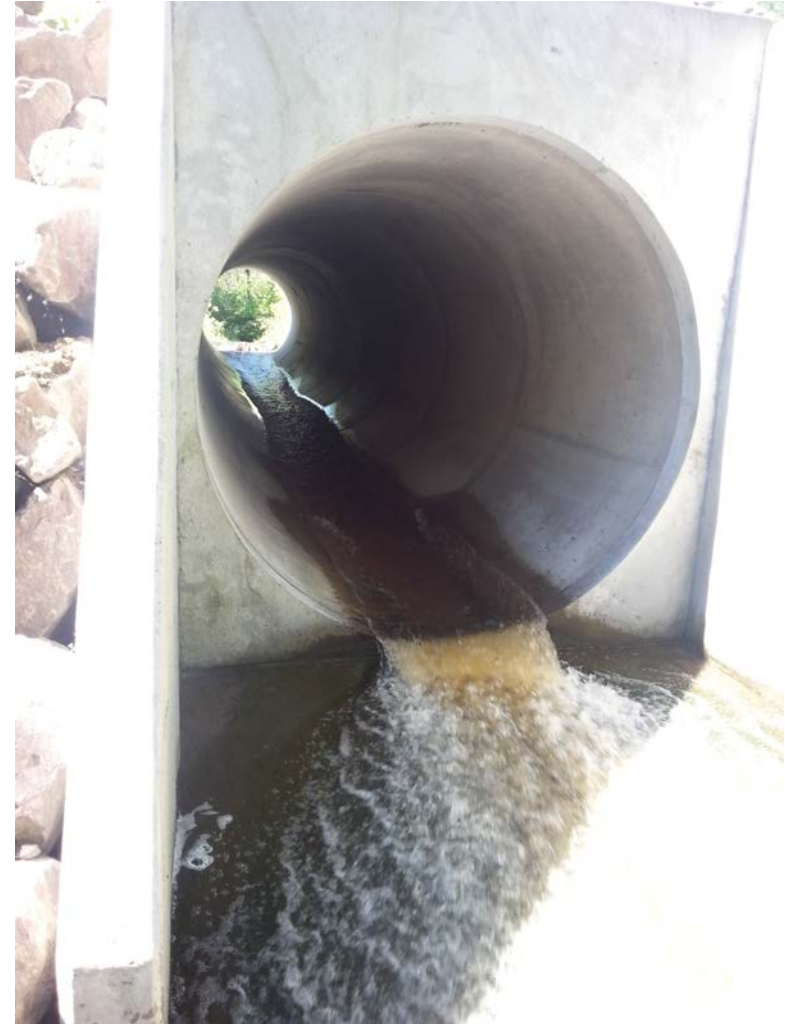
Fig. 22. Le ponceau présente une pente hydraulique de 7^\circ amenant ainsi une accélération de la vitesse d'écoulement de l'eau et créant par le fait même un obstacle infranchissable pour le poisson.
