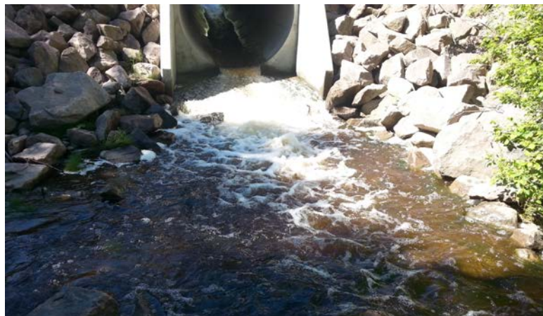
Fig. 18. Fosse en aval d'un ponceau aménagé pour le cours d'eau CE200. Le substrat du lit est composé de blocs, de gravier, de sable et d'argile.
