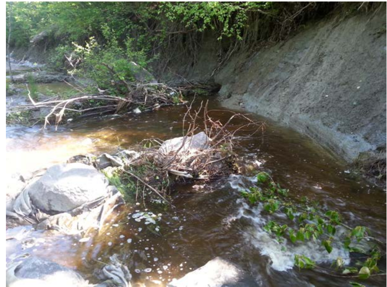
Fig. 17 Autre photographie du seuil observé à la station de pêche électrique. On remarque beaucoup d'érosion dans les bandes riveraines du cours d'eau à cet endroit.
